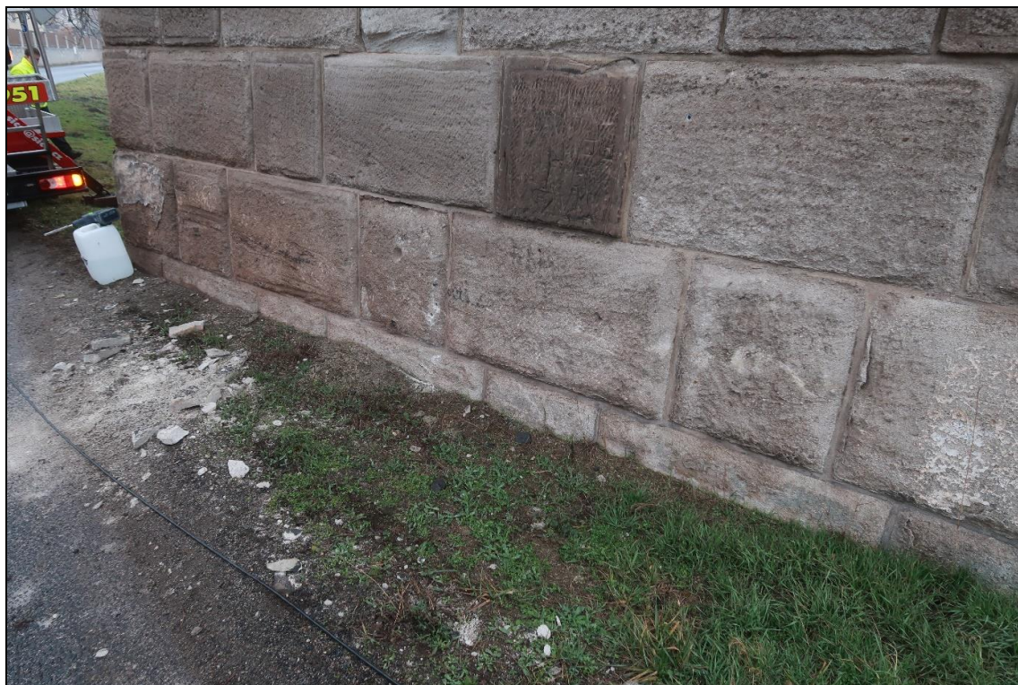
Foto 23: Odběr solí, pilíř P4, výška cca 0,25 m nad terénem, vzorek VZ1
