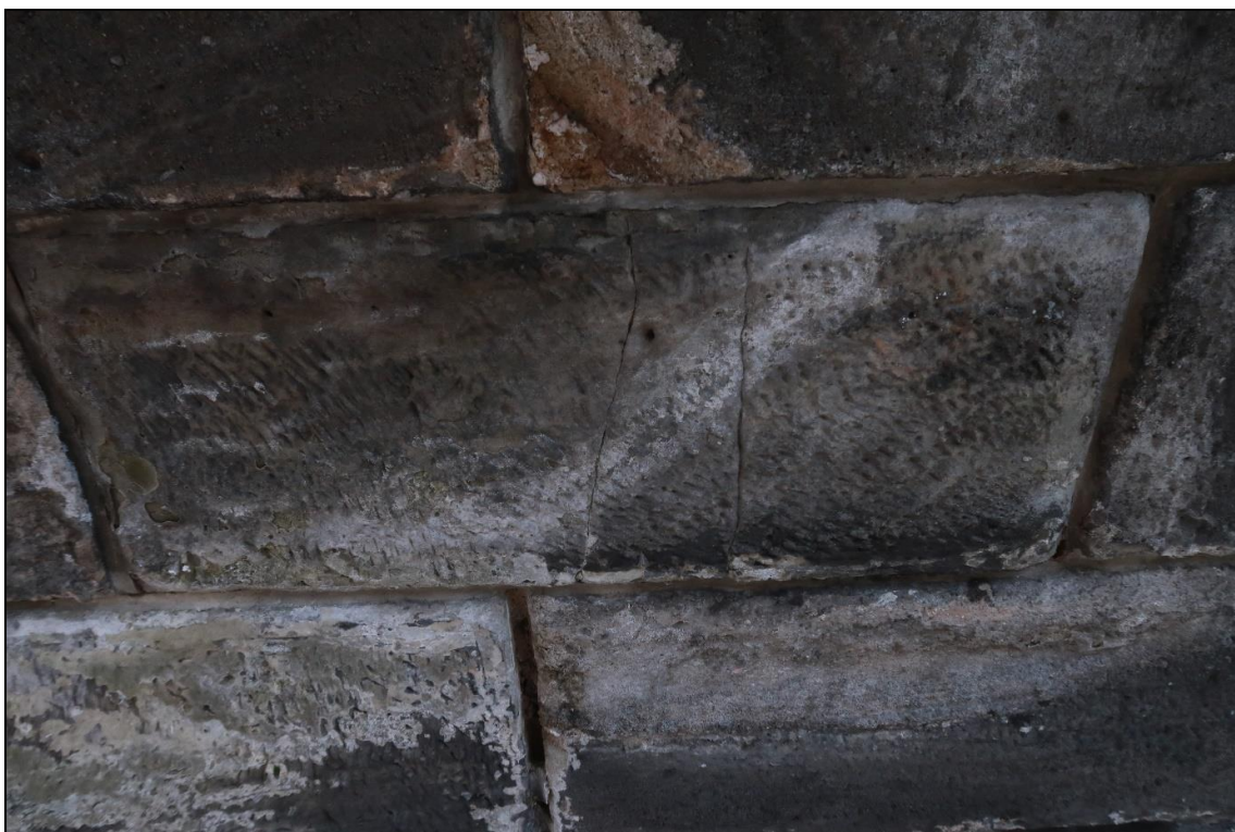
Foto 18: Pole 2, pohled na kámen obsahující trhliny (cca \frac{1}{4} rozpětí klenby)
