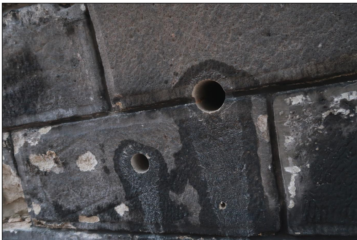
Foto 6: Pole 5, detail provedených vývrtů V1 (kámen) a V5 (spára)
