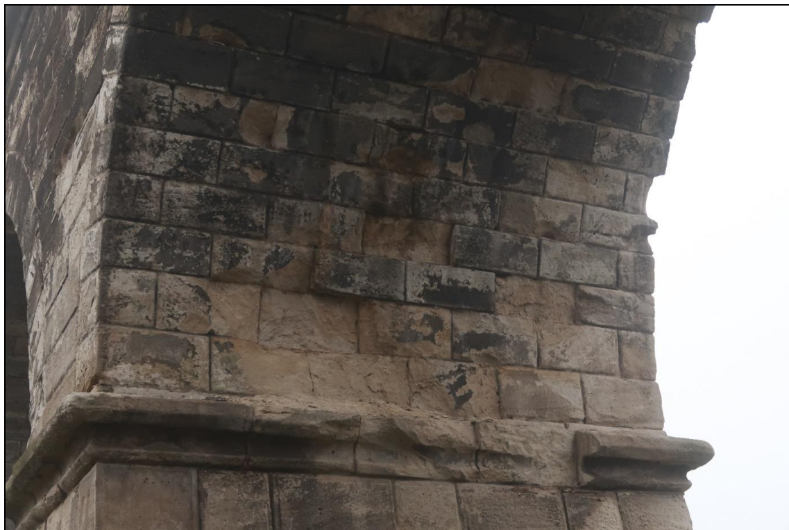
Foto 11: Pole 4, oblast nad římsou, směrem k nižšímu pilíři, výrazná degradace kamenů vlivem vody a mrazu
