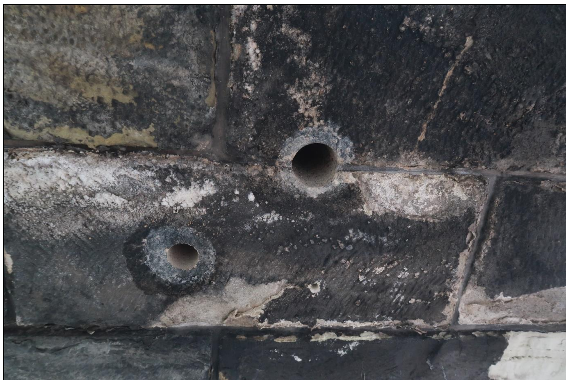
Foto 16: Pole 2, pohled na vůrt 3 (kámen) a vůrt 6 (ložná spára)
