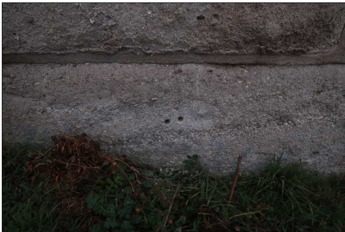
Foto 28: Odběr solí, pilíř P4 (čelo), výška cca 0,2 m nad terénem, vzorek VZ3 - detail
