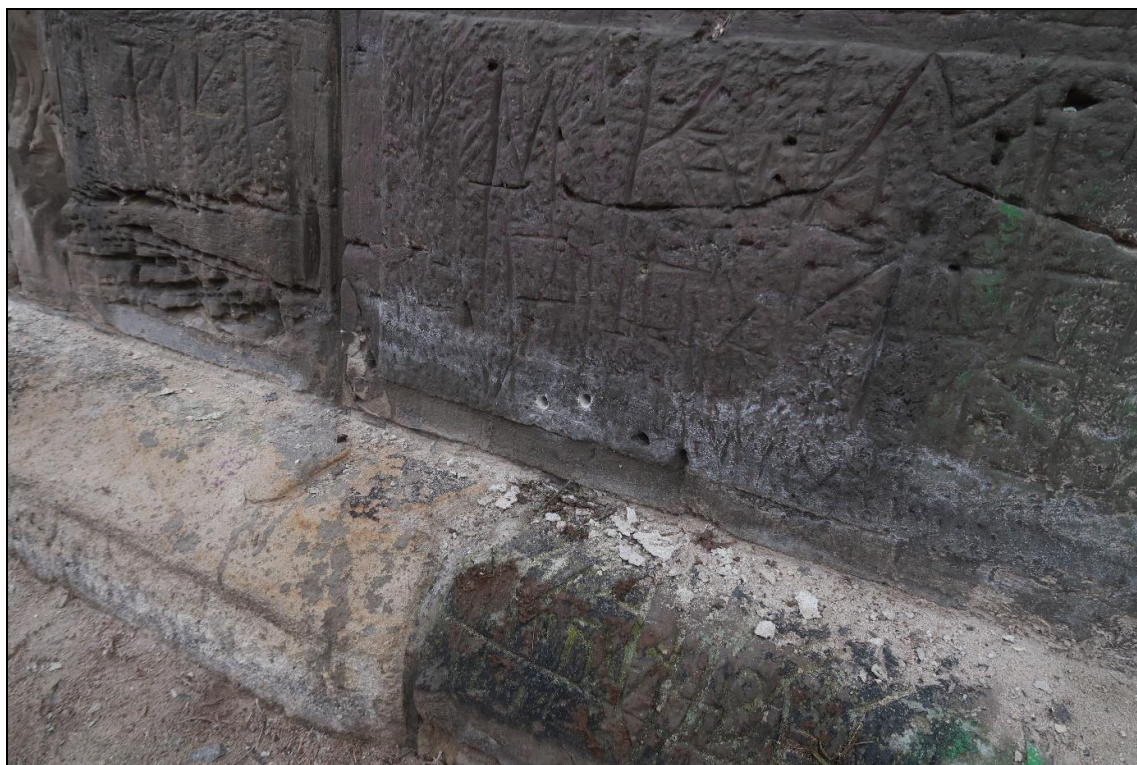
Foto 29: Odběr solí, pilíř P2, výška cca 0,2 m nad terénem, vzorek VZ4 – detail (odběr v místě bílého výluhu)
