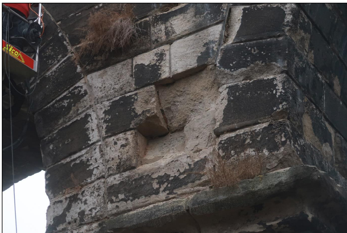
Foto 10: Pole 5, detail z fotografie 9, degradace kamenů do hloubky až 300 mm
