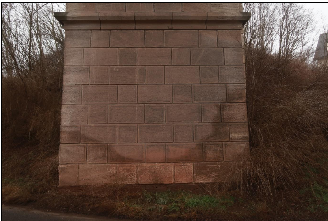
Foto 8: Pole 5, pohled na opěru mostu, na fotografii je viditelná vlhkostní mapa směrem od terénu
