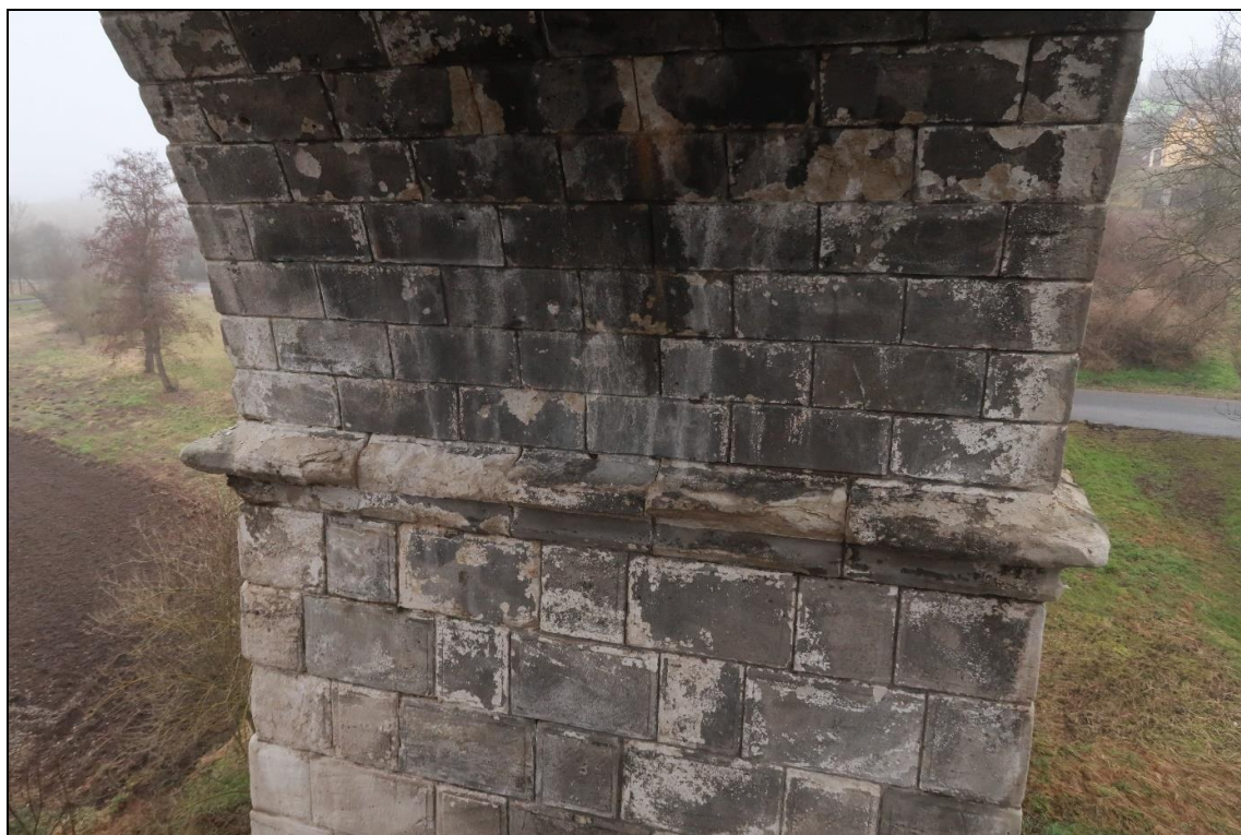
Foto 14: Pole 2, pohled na oblast římsy směrem k vyššímu pilíři, kamene římsy silně degradovány, probíhá výrazný rozpad do hloubky cca 150 mm
