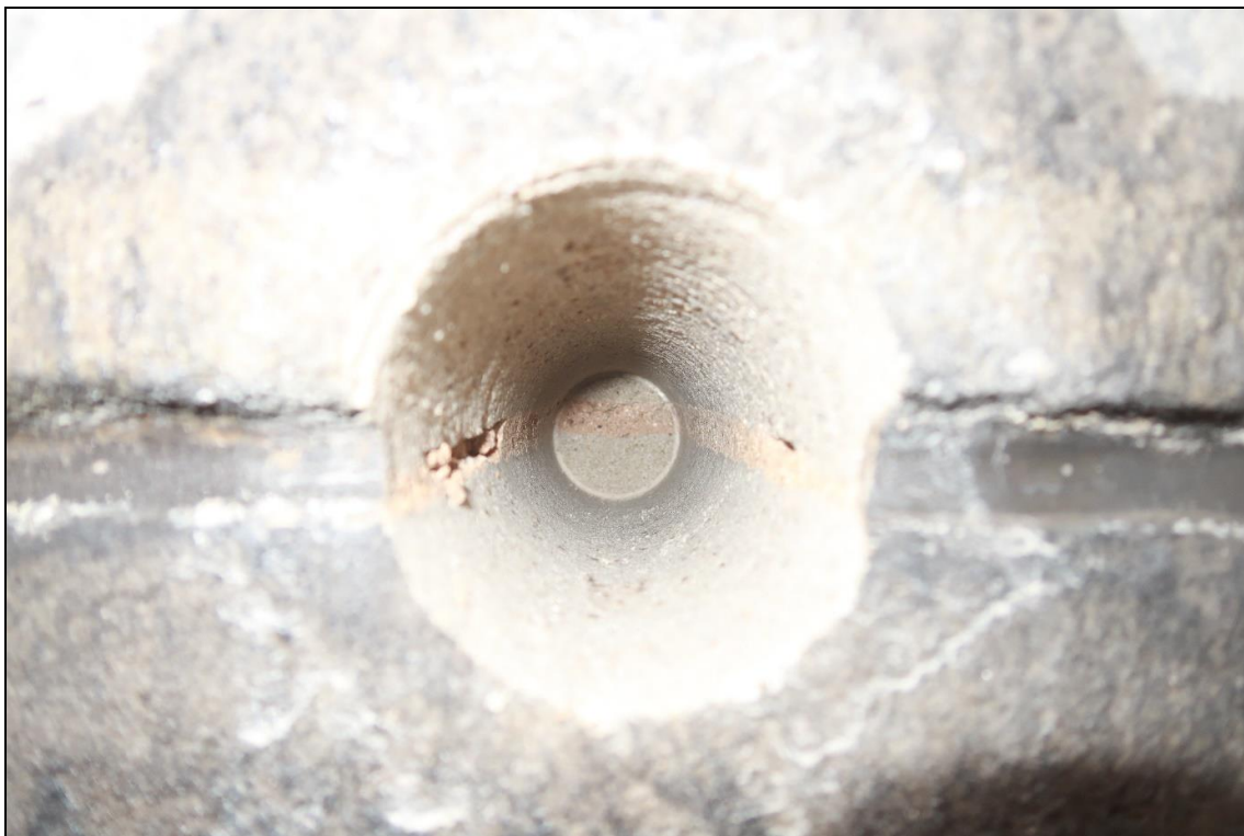
Foto 7: Pole 5, pohled do vývrtu V5, v hloubce cca 80 až 100 mm je patrná nevyplněná spára
