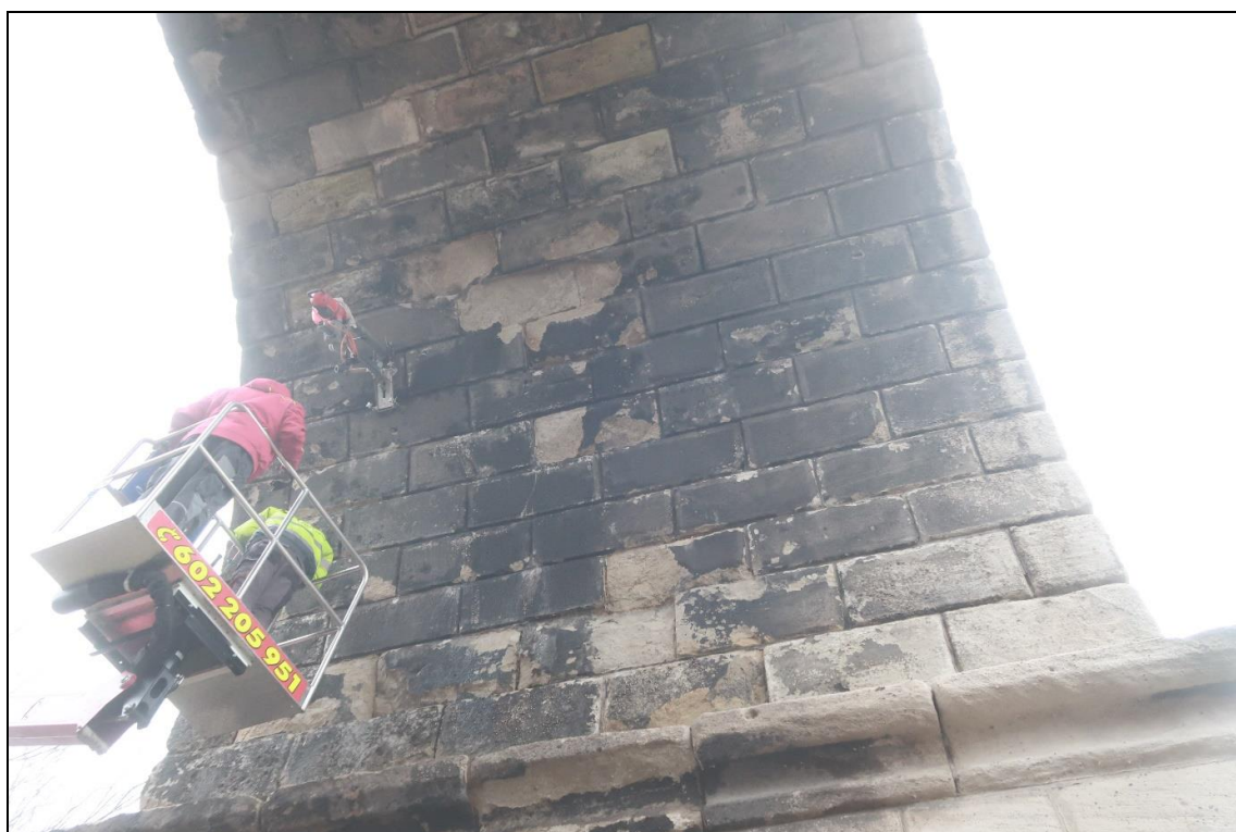
Foto 2: Dolní líc pole 5, místy dochází k rozpadu povrchových vrstev pískovce do hloubky 150 až 200 mm, spodní líc ve většině plochy pokryt černou krustou
