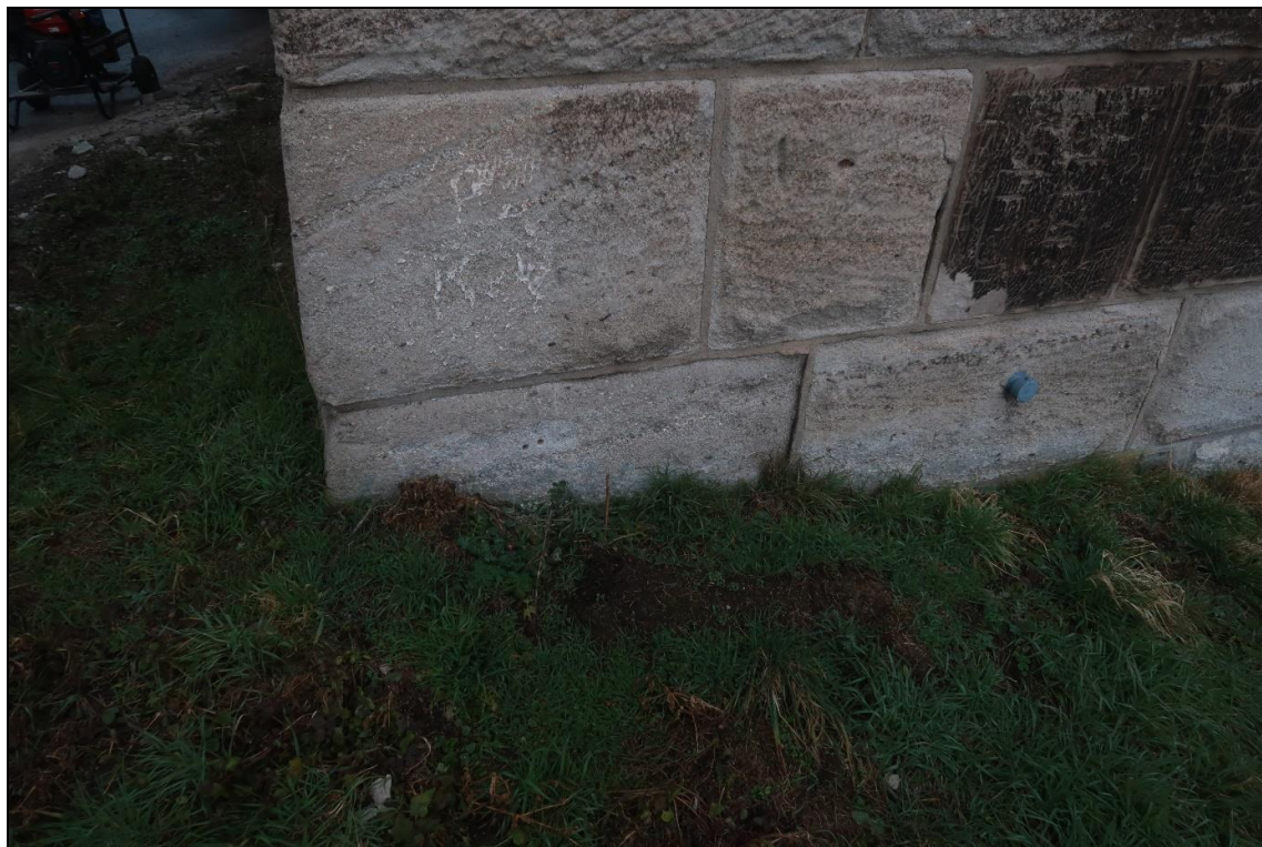
Foto 27: Odběr solí, pilíř P4 (čelo), výška cca 0,2 m nad terénem, vzorek VZ3
