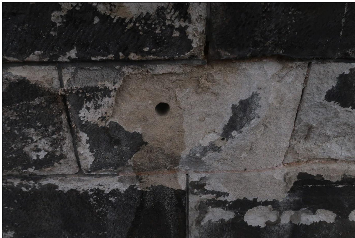
Foto 15: Pole 2, pohled na vůrt 4, vůrt proveden do kamene s povrchovou degradací
