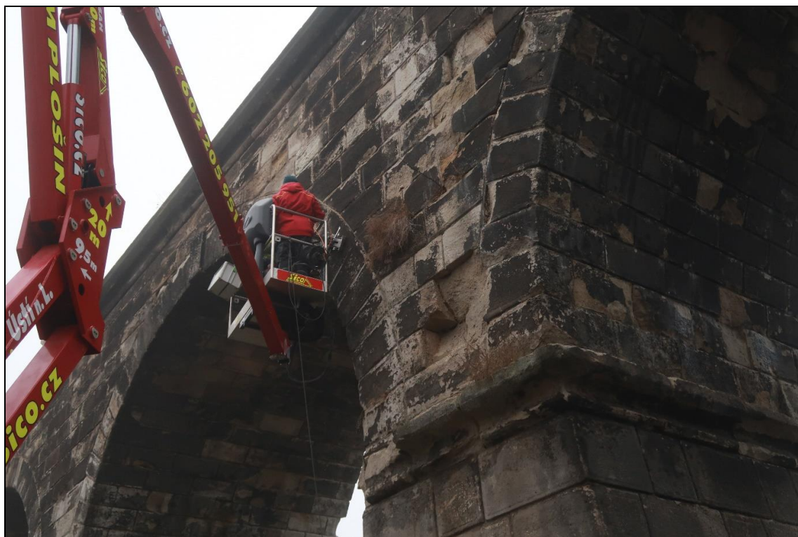
Foto 9: Pole 5, pohled na pilíř směrem k Podlešínu, v kalhotách mezi klenbami přítomny výrazně degradované kameny
