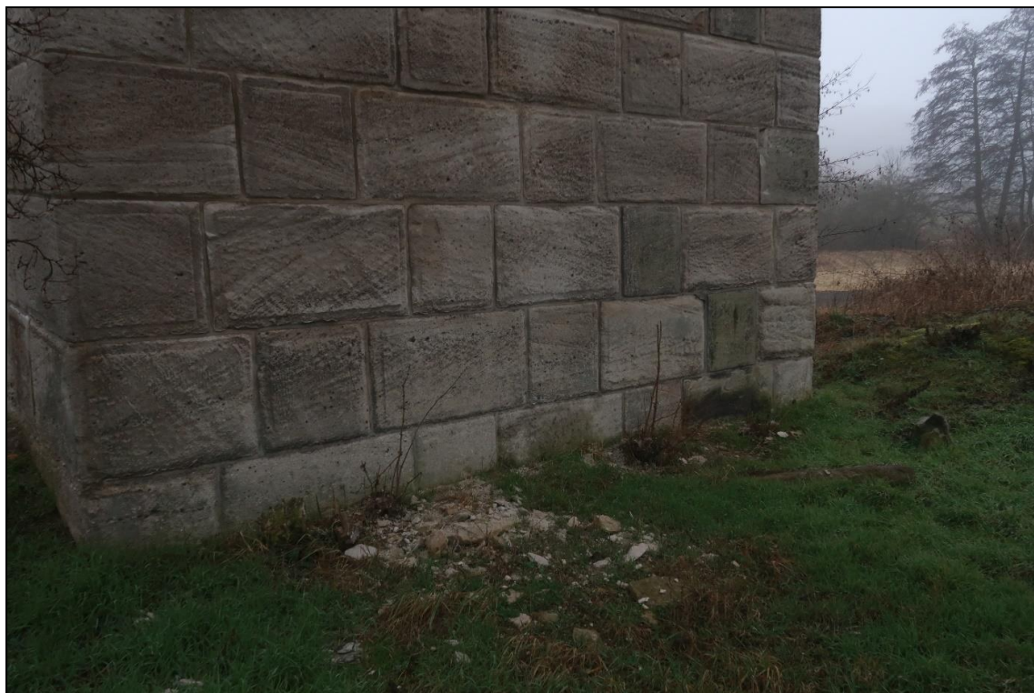
Foto 12: Pole 4, kusy pískovce odpadávající pod klenbu
