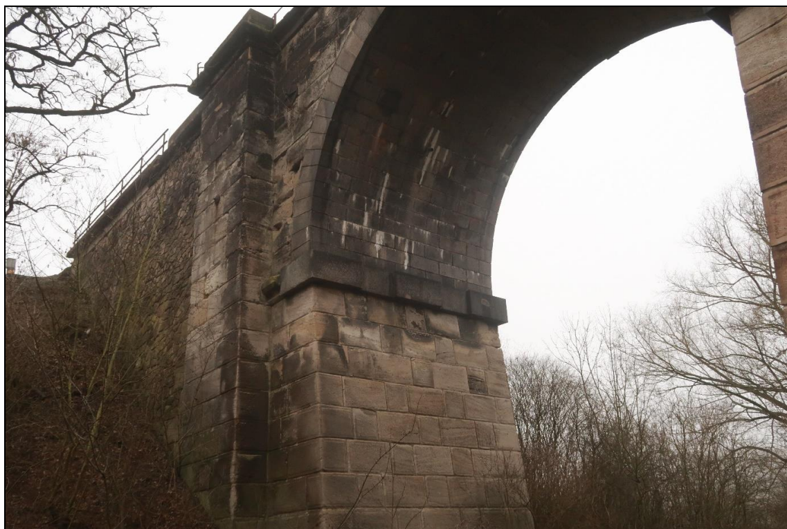
Foto 21: Pole 1, klenba nad vodotečí, pilíř z pískovce, klenba granitoid (počíná římsovým kamenem)
