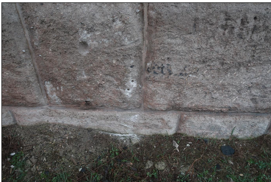
Foto 24: Odběr solí, pilíř P4, výška cca 0,25 m nad terénem, vzorek VZ1 - detail
