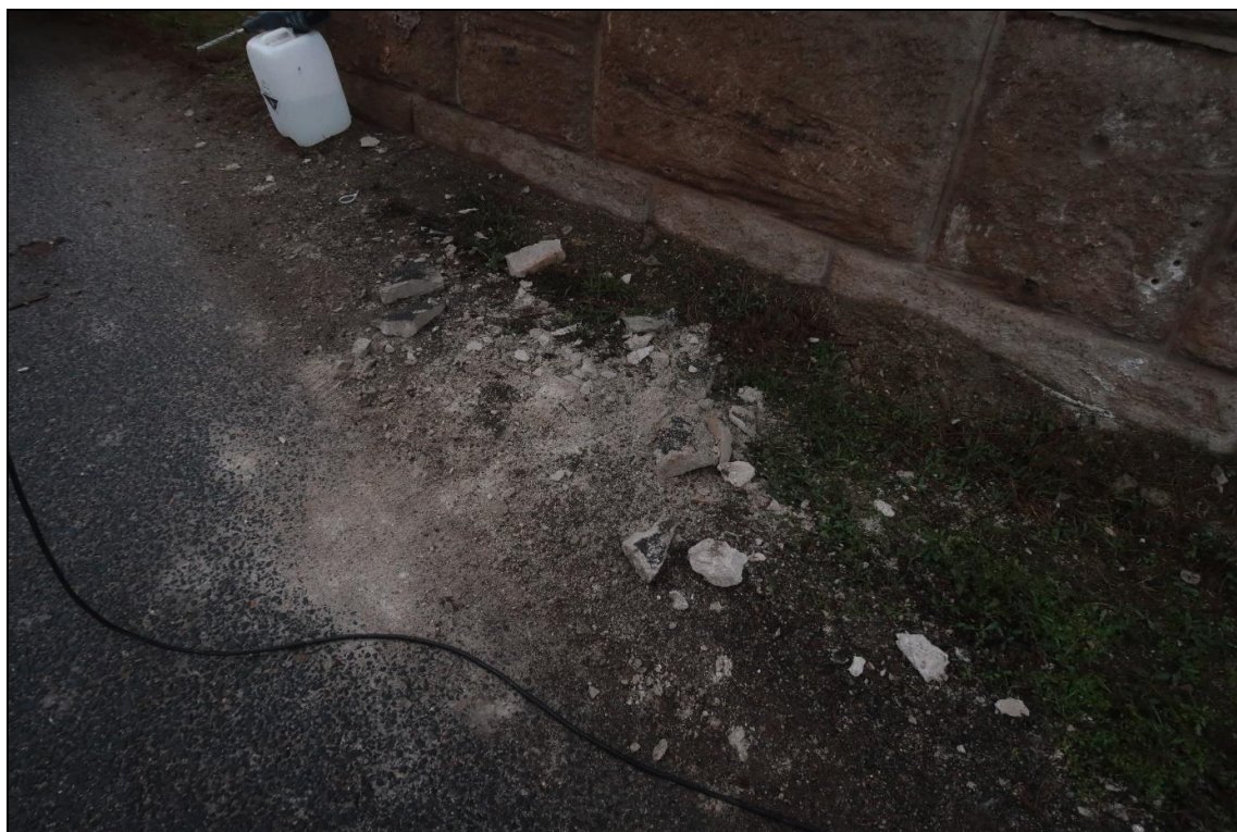
Foto 5: Pole 5, část odpadávajících povrchových vrstev na přilehlé komunikaci, na krajnici odpadávají kusy o váze až 1 kg
