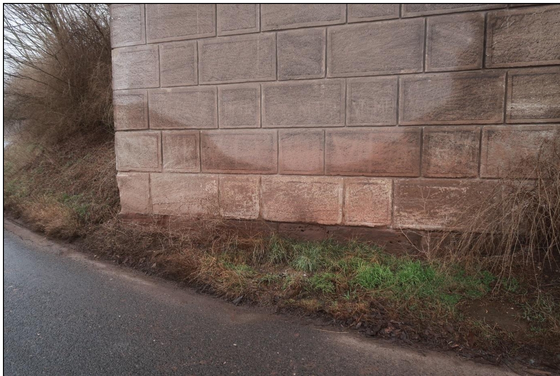
Foto 25: Odběr solí, opěra O2, výška cca 0,15 m nad terénem, vzorek VZ2
