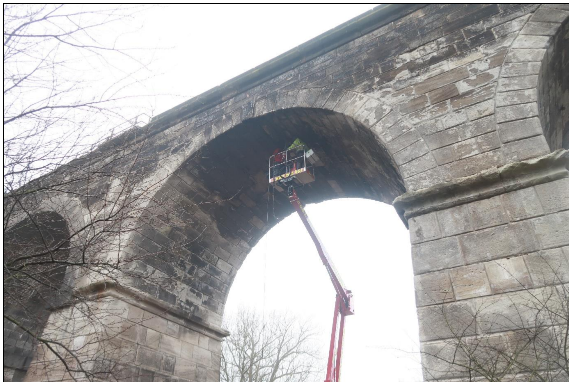
Foto 13: Pole 2, klenba nad cyklostezkou, klenba ve většině plochy pokryta černou krustou
