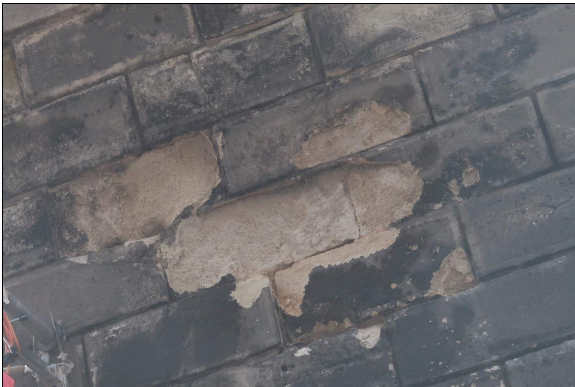
Foto 3: Detailní pohled na odpadávající povrchové vrstvy kamenů klenby (hloubka 150 až 200 mm), kameny mokré
