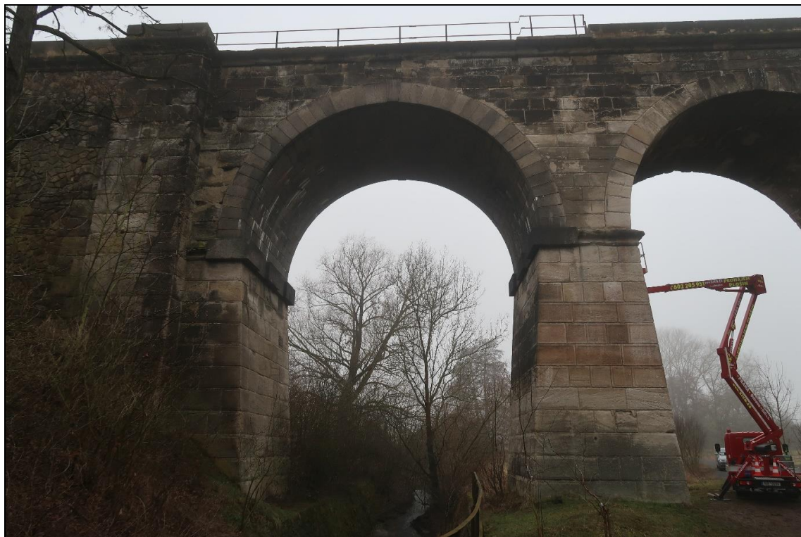
Foto 19: Pole 1, klenba nad vodotečí, jiný formát zdiva, vyzděna z granitoidů (žuly)
