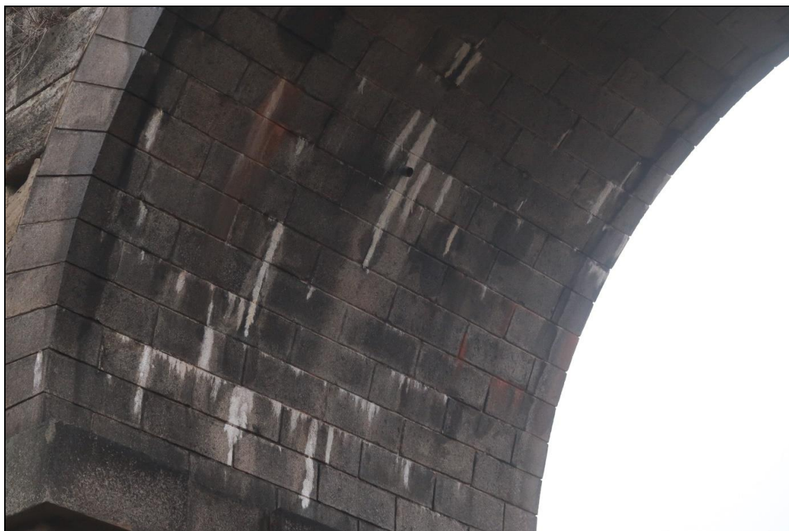
Foto 20: Pole 1, klenba nad vodotečí, pohled na dolní líc klenby, žulové zdivo, ze spár je vyluhováno pojivo
